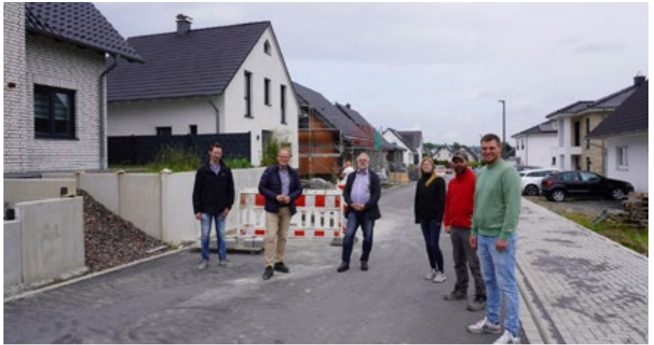
Rückblick auf das erfolgreiche Erschließungsprojekt „An der Chaussee“: V. I. Thomas Rastbichler (Ingenieurbüro Duksa), Bürgermeister Martin Michalzik und Christian Drees (Gemeindeverwaltung), Markus Hennersdorf und Felix Ständker (Stricker Infrastrukturbau)
